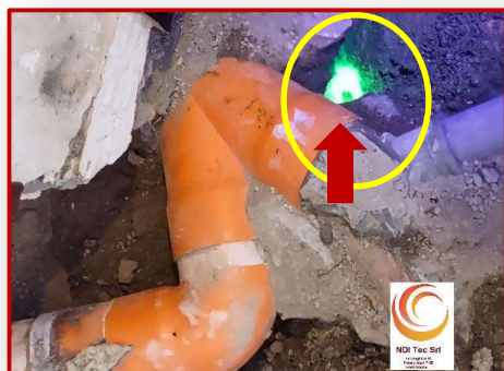
Ricerca perdite con particelle fluorescenti
