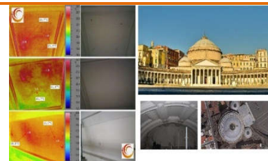
Rilievi termografici presso Basilica Reale pontificia San Francesco da Paola – Piazza Plebiscito (Na)
