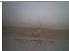
Rilievi termografici per verifica infiltrazioni da solaio di copertura Gennaio 2014
