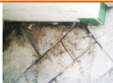
Verifiche infiltrazioni per perdite da tubazione - Giugno 2019
