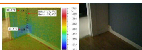
Rilievi termografici per verifica infiltrazioni da sistema di riscaldamento sotto-pavimento
