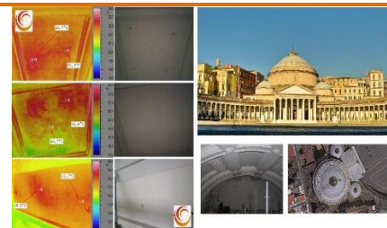
Rilievi termografici presso Basilica Reale pontificia San Francesco da Paola – Piazza Plebiscito (Na)
